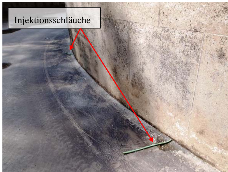
Abbildung 3: Injektionsschläuche in der Fuge zwischen Boden und der Innenwand des Belebungsbeckens (Trennwand zum Nachklärbecken)
