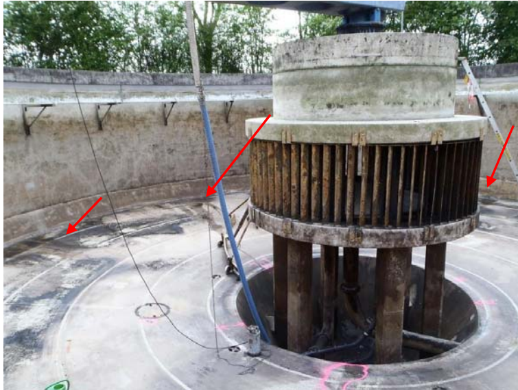
Abbildung 7: Undichtigkeiten im Bereich der Fuge, radiale Wasserspuren
